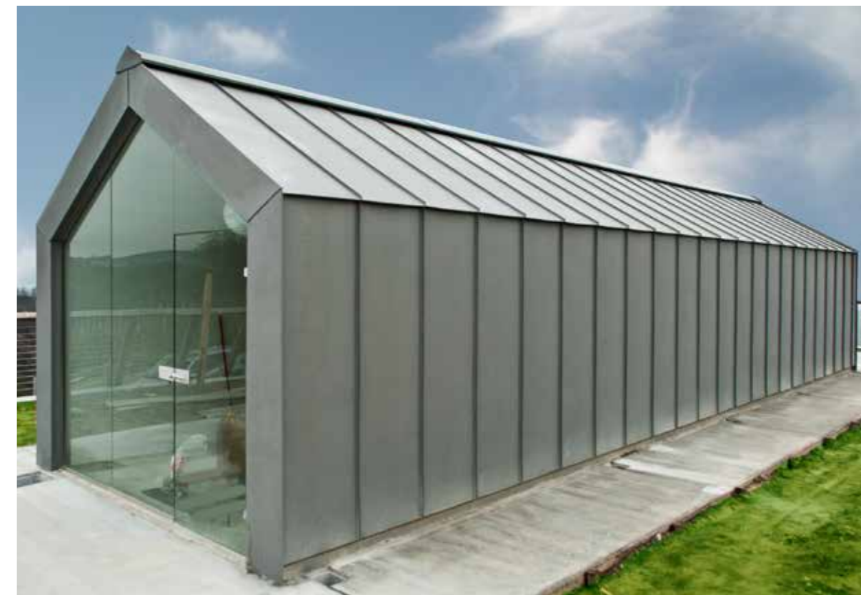
● Capannone con rivestimento in zinco titanio in doppia aggraffatura
