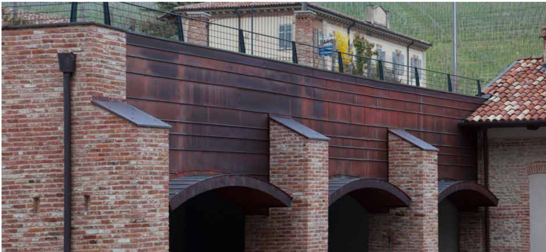
● Cantina Barolo con rivestimento in rame in doppia aggraffatura. Sotto, concessionaria con facciata in zinco titanio a doghe
